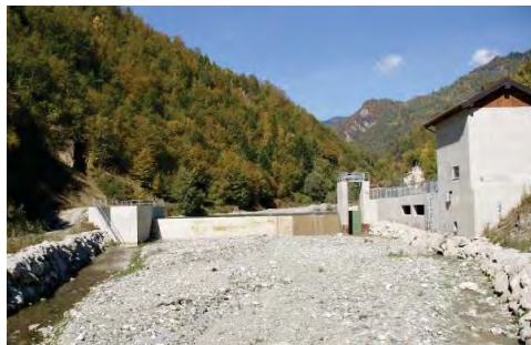
Foto nr. 110. Degradimi i shtratit të Lumbardhit në Deçan
