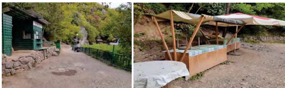
Foto nr. 59 dhe 60. Ndërhyrjet në zonën e mbrojtur
